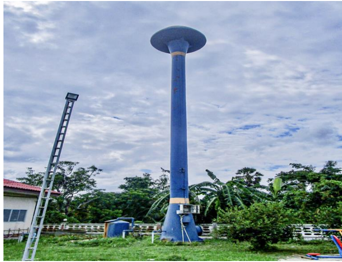
ถังประปาบ้านนายประยงค์ (กอไผ่) ม.๕ พิกัด E. ๖๑๐๒๘๕ N. ๙๓๔๘๙๙
