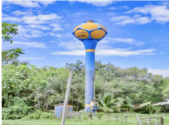
ถังประปาบ้านบังปิติ ม.๖ หมายเลขบ่อ MH๙๑๐ พิกัด E.๖๑๔๔๒๕ N.๙๔๐๘๐๐
